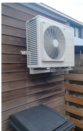
Installatievoorbeeld tegen een uitbouw
